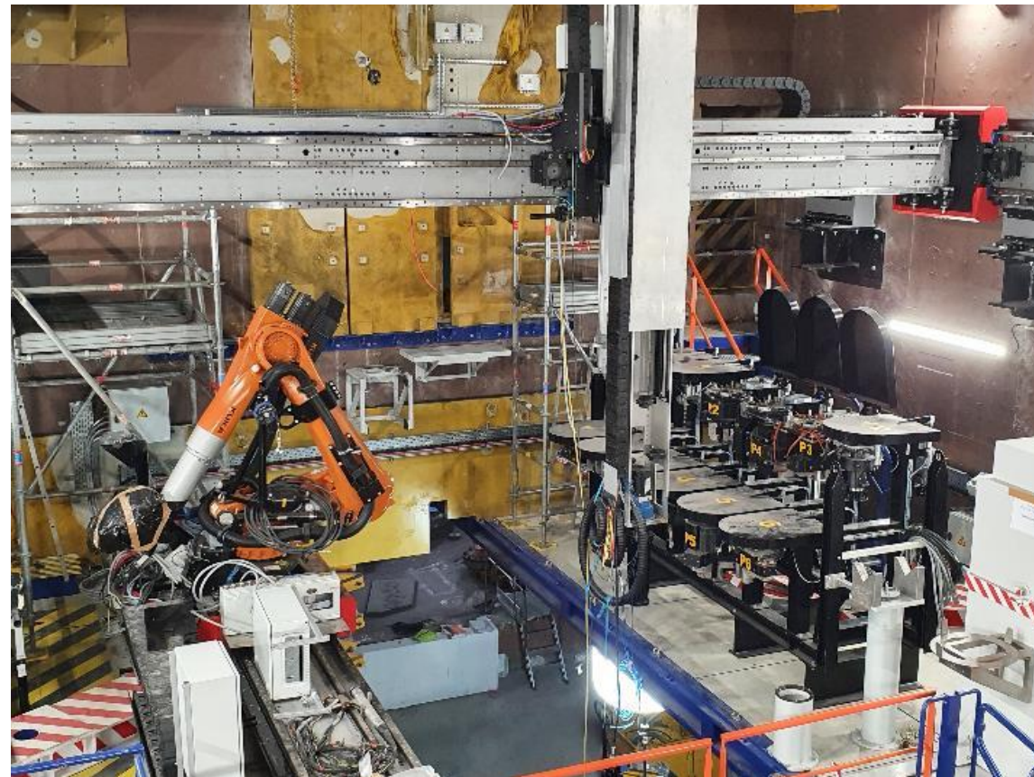
Préparation de l'atelier de démantèlement des internes de cuve
